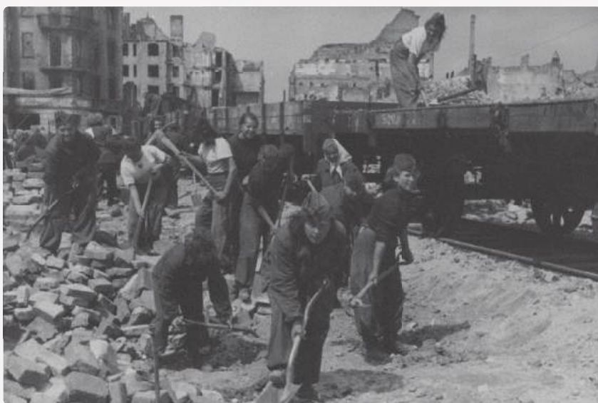
Odgruzowywanie Gdańska przez kobiecą brygadę „Służba Polsce”. Fot. J. Uklejewski, 1948. Zbiory MIIWS.
